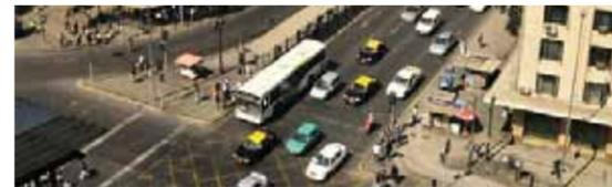
La calzada de dos vías de transporte privado se reduce en esta transición de 6,5 m a 6,25 m y las de transporte público se mantienen de 7 m, dando un perfil de calzada hasta la calle Placer de 13,25 m, en total.
